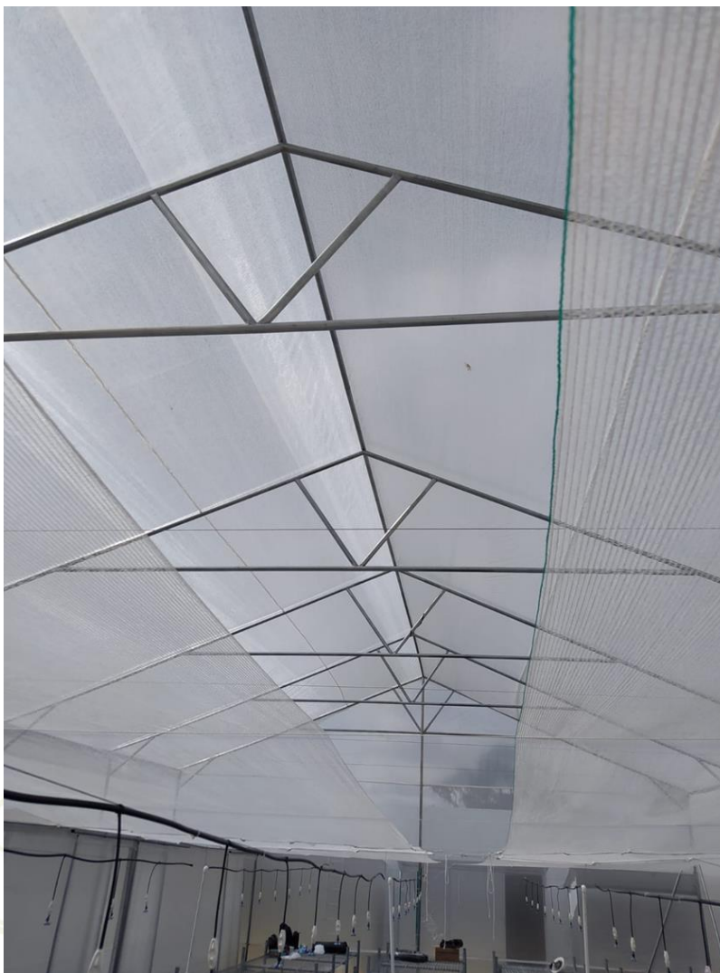
Figura 2. Detalle de polisombra blanca sobre camas de producción de minitubérculos.
