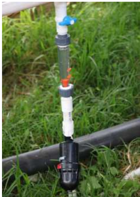
IMAGEN 26. ROTÁMETRO Y FILTRO DE ANILLOS
