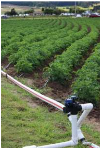
IMAGEN 20. MONTAJE ELECTROVÁLVULA
